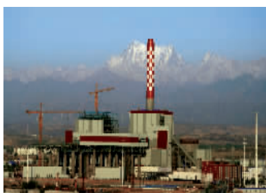
公司承建的神华新疆米东热电厂。
