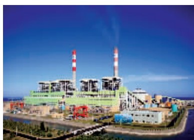
公司总承包建设的广东惠来电厂1000MW机组。
