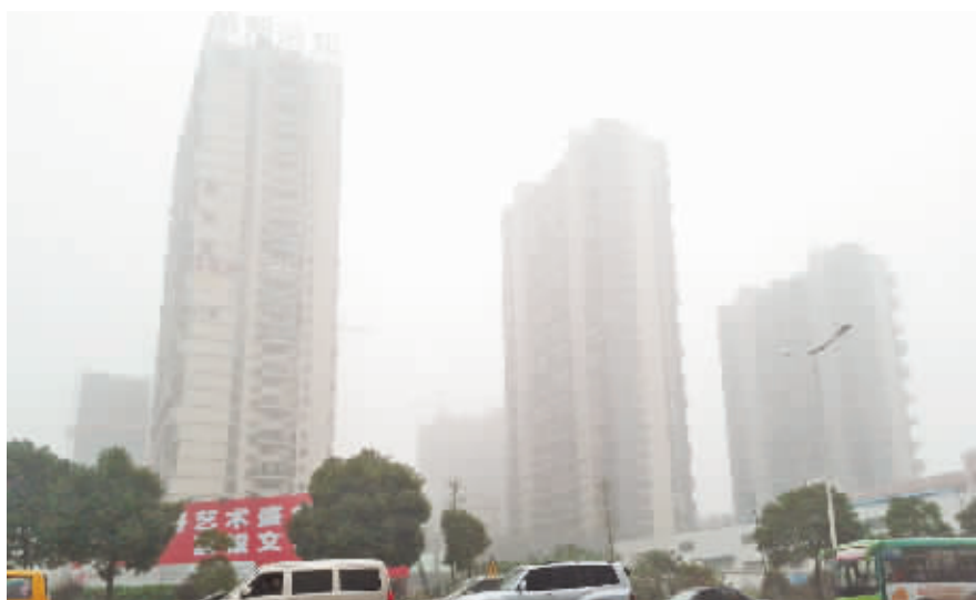
湘潭市中心城区，一座30多层的商业楼盘——晶都公馆，仅凭几份假冒(伪造)的审批材料就层层过关，获得建设工程竣工验收《备案证》。
