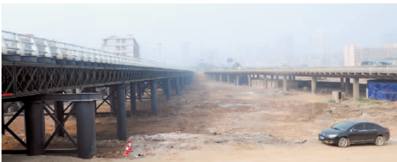
11月22日,长沙市三一大道浏阳河钢便桥(左)即将投入使用,已成危桥的浏阳河老桥(右)随即关闭。记者 龚磊 摄
