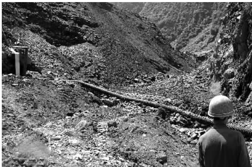
2011年7月21日深夜2时左右，四川松潘县小河乡境内突发强降雨，山洪泥石流造成四川岷江电解锰厂渣场挡坝部分损毁，泥石流卷走部分矿渣，冲入河道造成涪江污染。
