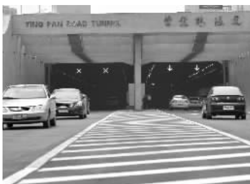
10月29日下午,长沙市营盘路湘江隧道,很多小车通过隧道过江。当日,该隧道正式建成通车。
