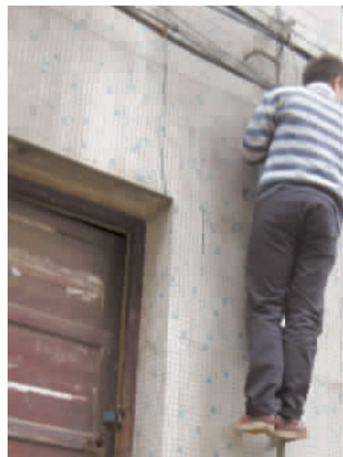
燃气管道经地面沿楼栋外墙直达顶层,常人也可顺着管道攀爬至楼上。 记者 李永亮 摄
