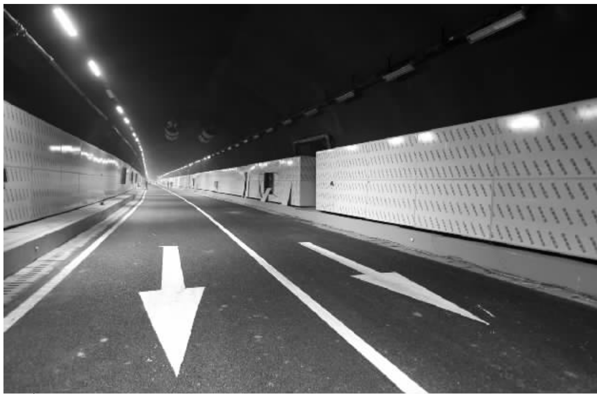
10月20日,长沙市营盘路湘江隧道,经过大半个月的装饰装修,隧道内宽敞明亮,该隧道将在月底正式通车。
