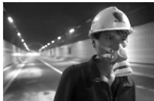
隧道内还在钻孔装风机,由于扬起的灰尘太大,工人得戴着防尘口罩。
