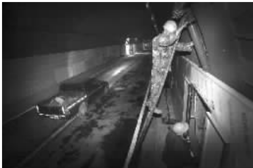
工人们在安装消防管道,如果隧道内发生火灾,消防管道将发挥作用。
