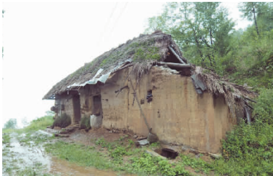
重庆市开县大进镇关坪村一位村民的房屋已经局部垮塌(9月17日摄)。 新华社 图
