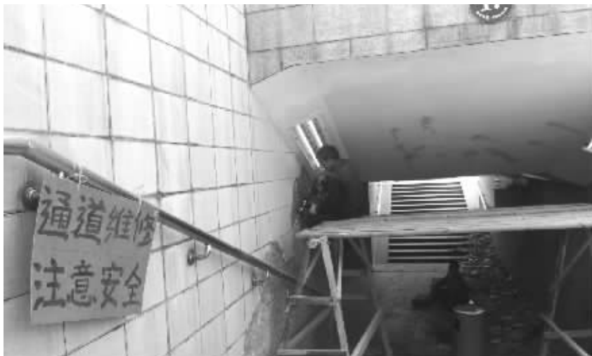
7月29日,长沙市芙蓉路17号通道正在维修施工。 记者 龚磊 摄
