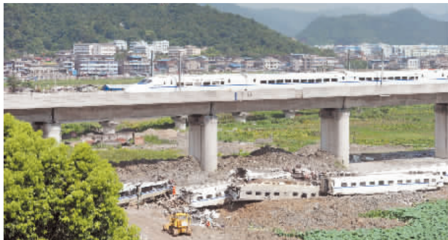
7月25日,一列列车驶过事故路段。铁路杭州站25日的动车开行基本恢复正常。 新华社 图
