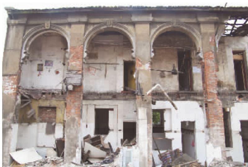
7月22日,长沙市楚湘街,交通银行旧址已经开始拆除。 记者 武席同 摄
