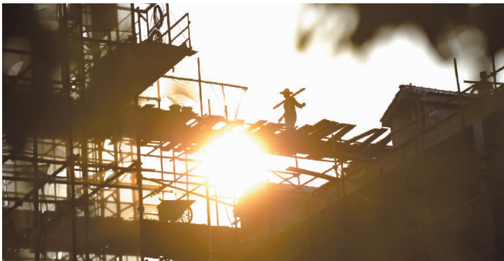
7月24日下午,长沙市开福区,几名建筑工人在烈日下施工。记者 田超 摄
