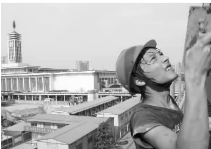
7月23日,长沙火车站售票大楼外层装饰,工人们顶着烈日工作。
