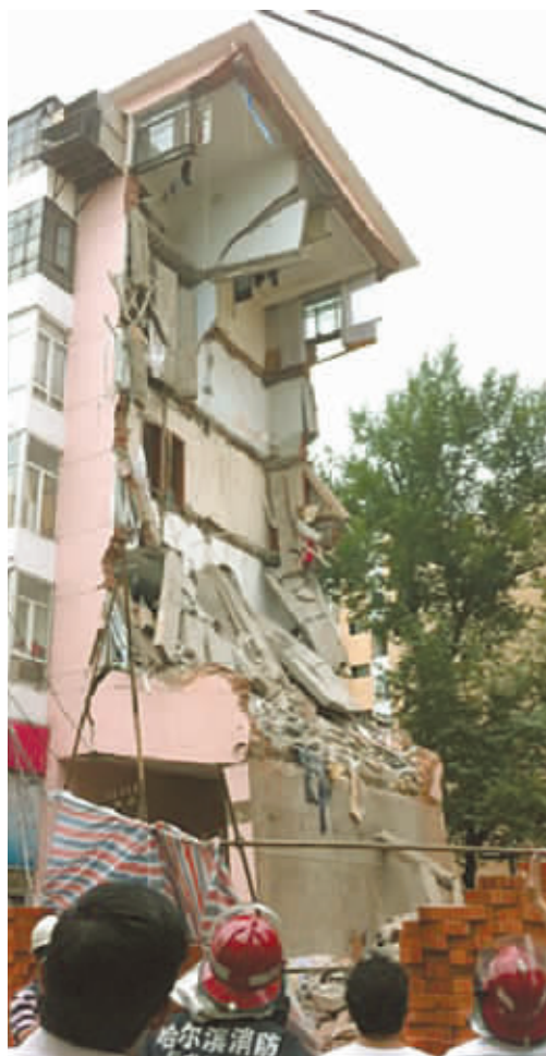
救援人员赶到现场,楼内居民已撤离。 新华社图
