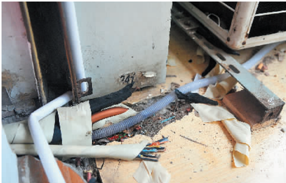
7月8日，长沙市芙蓉路三段109号，附近4家店铺的空调铜管一夜之间被人剪断。记者 伍霞 摄
