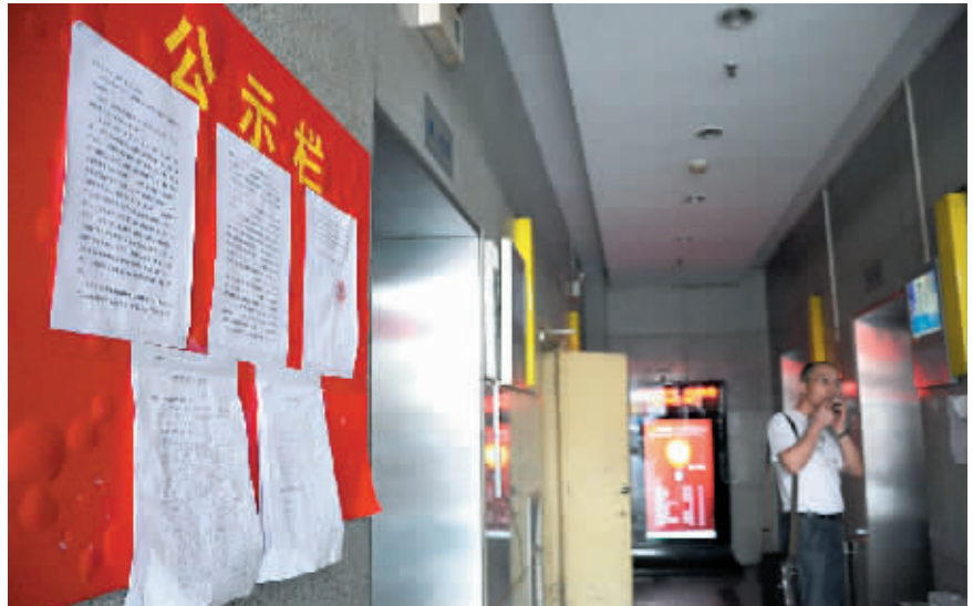
7月7日,长沙市蚂蚁工房,楼内4台电梯坏得只有一台能用,电梯旁物业管理公司在公示栏上贴着申请动用维修基金维修电梯的公示。傅聪 摄
