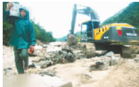
救援人员通过一段刚被挖掘机填出来的路面。
