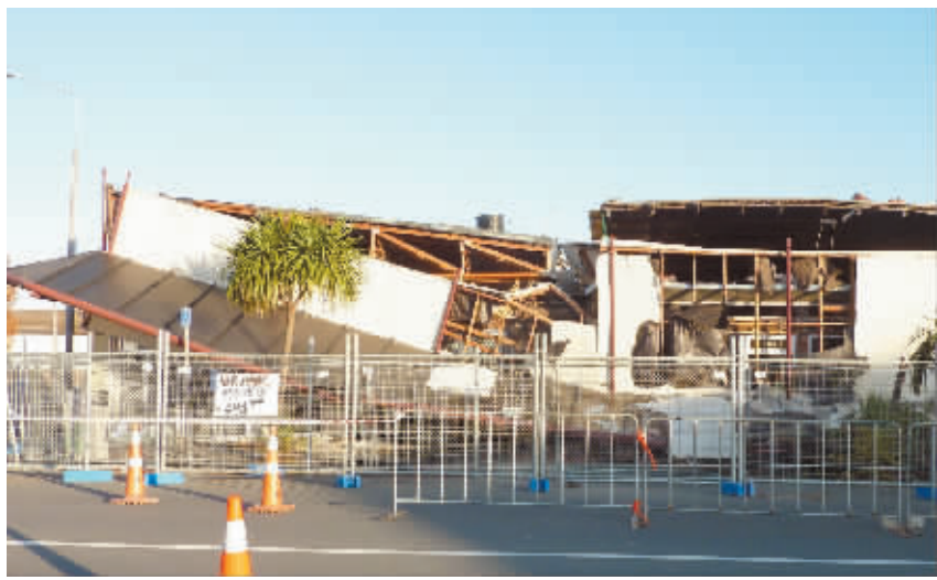
这张6月13日拍摄的照片显示的是，新西兰南岛城市克赖斯特彻奇发生余震后部分受损建筑。 新华社图
