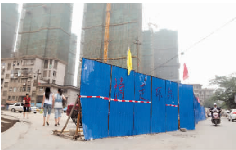
6月13日,长沙市德雅路与金帆路交叉路口,金帆路正在提质改造。记者 伍霞 摄
