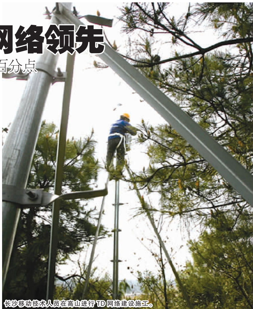
长沙移动技术人员在高山进行TD网络建设施工。
