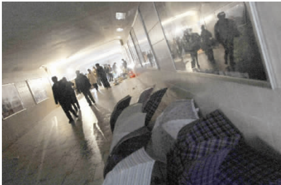
3月20日傍晚,长沙市芙蓉中路识字岭地下通道,由于供电线路故障,通道内的照明灯均不亮,只有几名小贩的自备电瓶灯发出一点点光亮。 记者 田超 实习生 陈杰 摄
