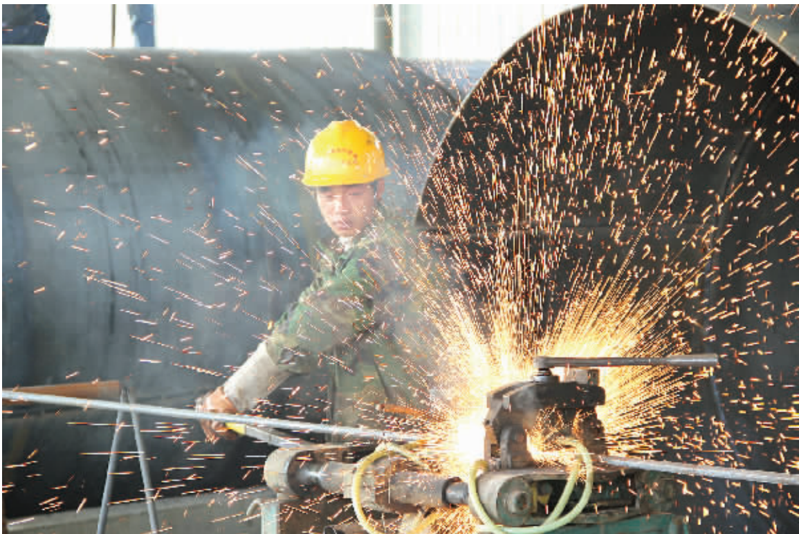
长株潭城际铁路湘潭湘江特大桥工地,一钢筋工师傅正紧张作业,现场钢花飞溅。 记者 刘晓波 摄
