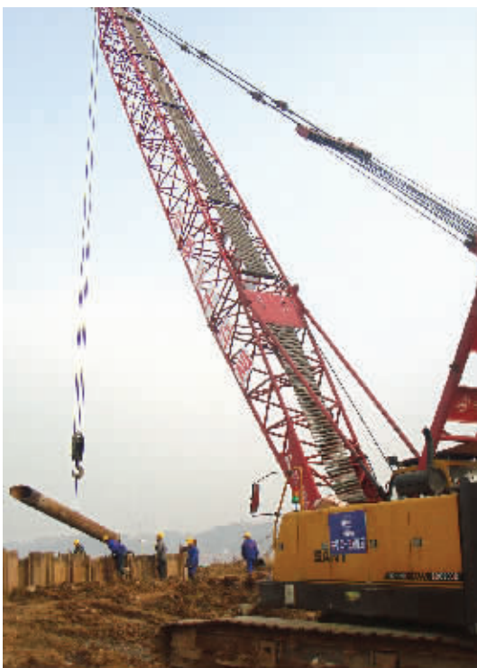
起重机将钢管吊装到围堰里。 记者 刘晓波 摄
