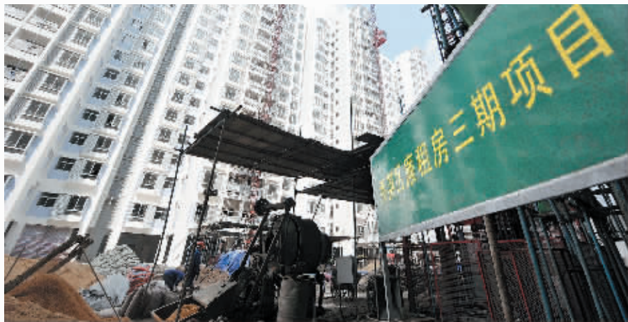
保障房今年被摆到了前所未有的重视高度。图为建设中的一处廉租房小区。 新华社图
