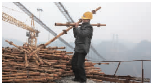
工地上，钢筋师傅忙碌的身影。记者 范远志 摄
