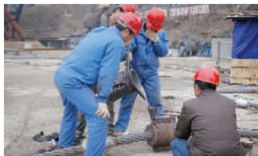
工人们给大桥钢索上浇灌液铸成型。记者 范远志 摄
