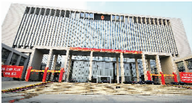
龙岩市市委、政府大楼。江进祥曾反映市政工程存腐败问题。 新华社图
