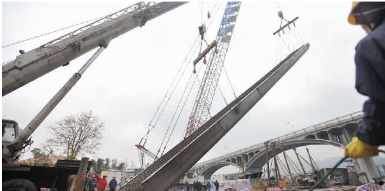
12月15日中午,长沙市橘子洲地铁站工地,施工人员冒着雨雪将40吨重的钢筋笼垂直吊起,放入指定位置。记者 田超 实习生 陈杰 摄
