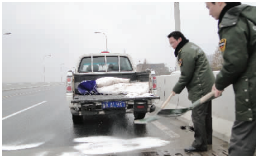
12月15日上午,岳麓区城管队员在路面撒盐除冰。
