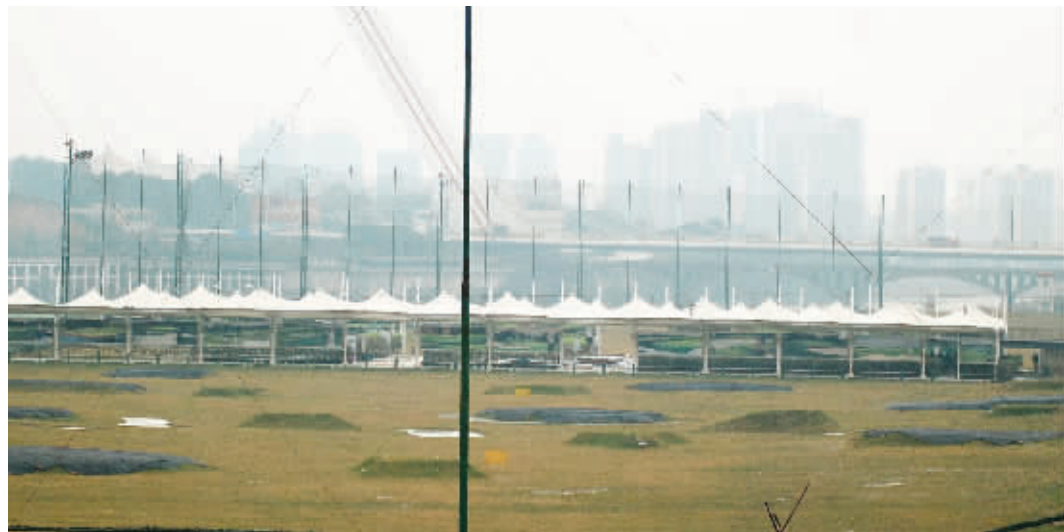
12月15日，长沙市浏阳河四方坪段，建在防洪大堤内的月岛高尔夫俱乐部被下令拆除。 实习生 陈杰 记者 田超 摄
