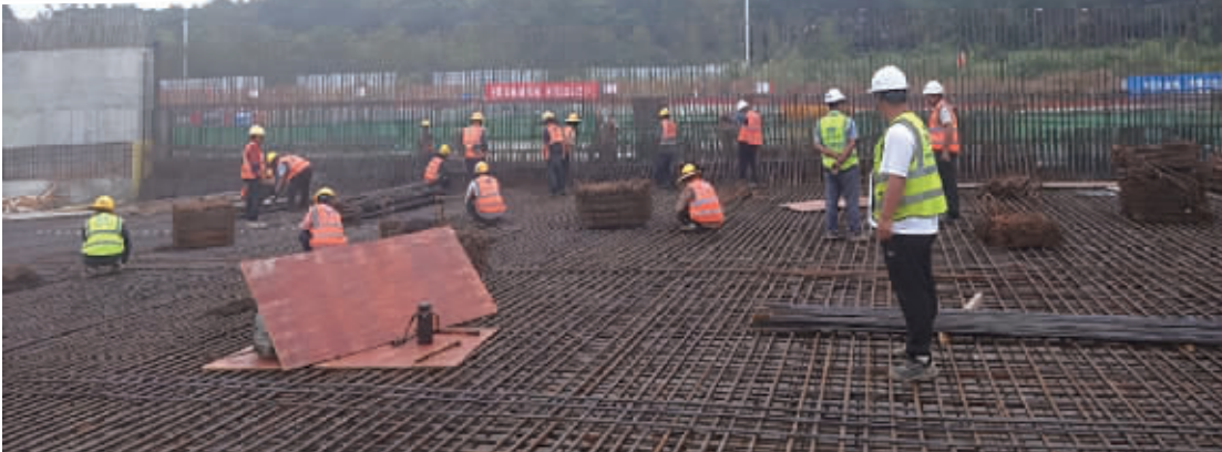
工程一标正在进行隧道B11区底板钢筋绑扎作业。受访者 供图
