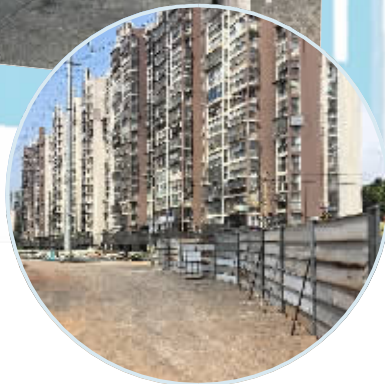
8月21日，记者在现场看到，雅塘冲路二期施工仍未完成。
