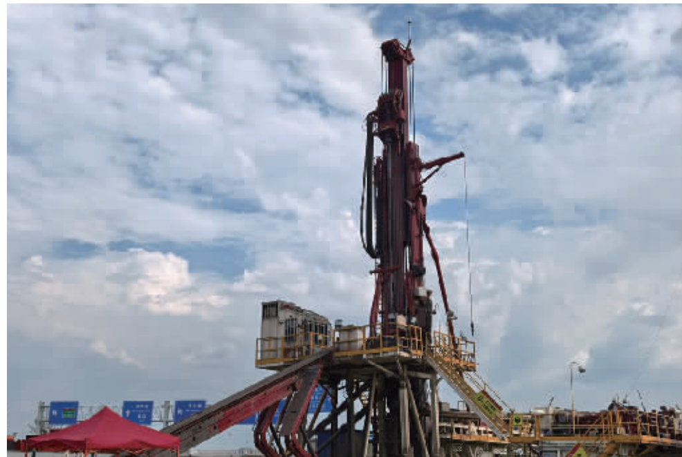
长沙机场绿色能源项目预计2026年底竣工。图为J5地热井完成钻探施工。 通讯员 供图
