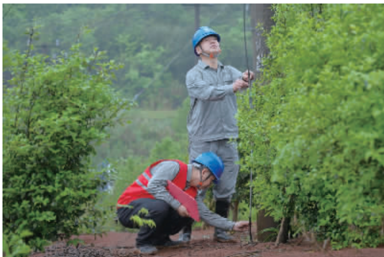
国网郴州供电公司工作人员开展台风来袭前输电线路特巡,排查管控防汛隐患点。 通讯员 供图
