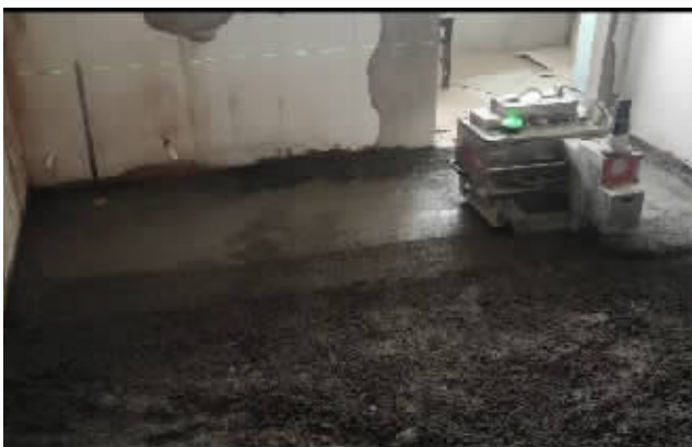
地面找平机器人在操作员指挥下精准作业。
