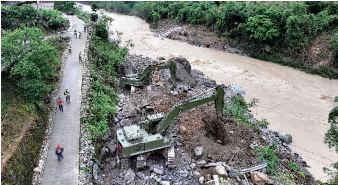
5月26日，石门县壶瓶山镇杨家坪村路段，武警部队的大型挖掘机正在现场进行抢通作业。
