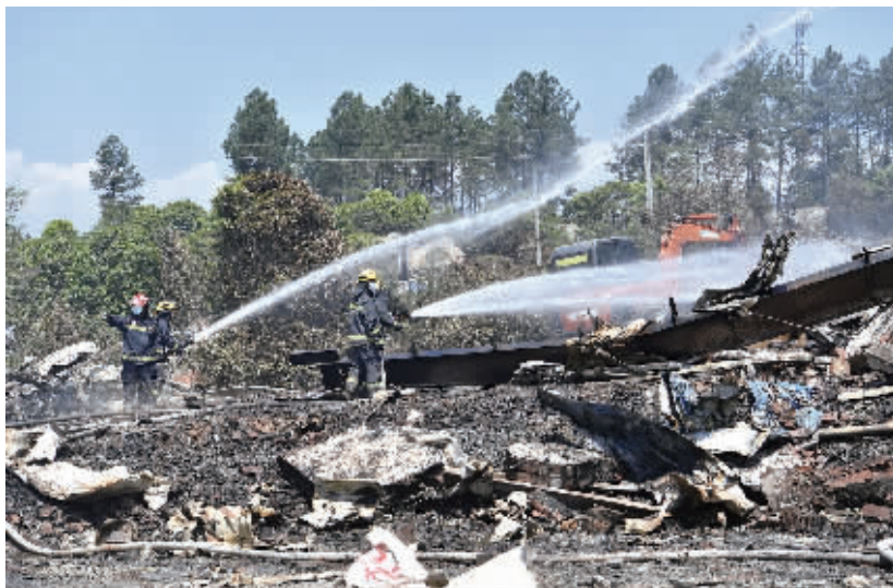
5月5日，浏阳市华盛烟花制造燃放有限公司，消防救援人员正在现场进行搜救排查作业。 湖南日报全媒体记者 童迪 摄
