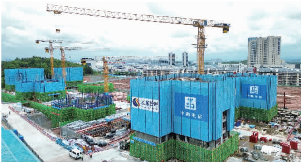
长沙奥体中心项目现场航拍图。受访者供图
