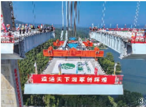
8月3日上午,在张官高速洞庭沅水特大桥施工现场,工人在吊装最后一节钢混组合梁。
