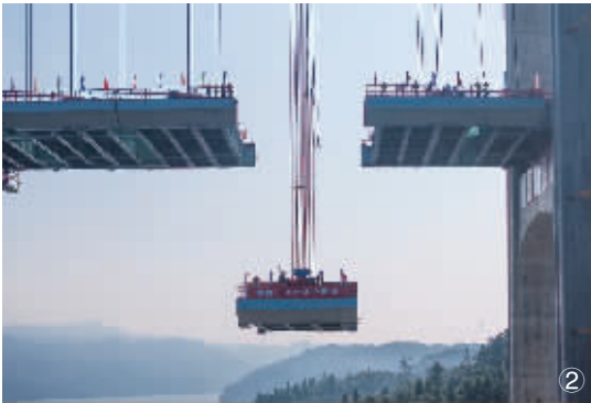
8月3日上午,在张官高速洞庭沅水特大桥施工现场,工人在吊装最后一节钢混组合梁。
