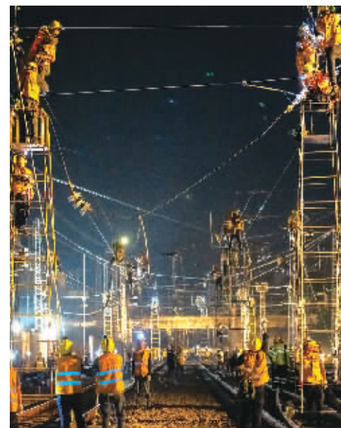
沪昆线怀化站接触网大修施工现场。 通讯员 供图
