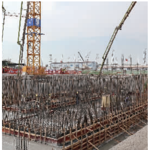
3月24日，长沙黄花机场改扩建工程综合业务用房及职工生活服务中心等工程项目现场，首块底板浇筑顺利完成。
