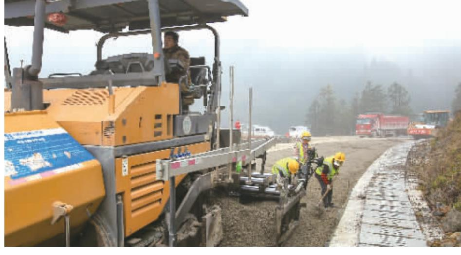
2月21日，龙山县茅坪乡桑（植）龙（山）高速公路连接线施工现场，工人在铺筑水稳层。桑龙高速公路是我省西北部一条重要的高速大通道，具有承接南北、连接东西的重要作用。
