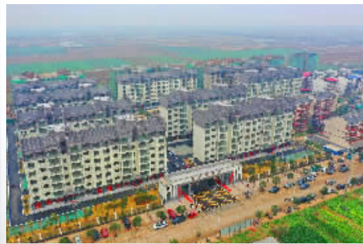
无人机拍摄的华容县团洲垸“团洲新村”。 新华社 组图
