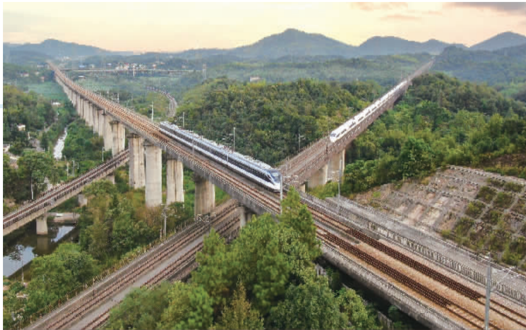
湘潭市岳塘区，长株潭城际铁路列车与京广高铁在此相遇。湖南日报全媒体记者 辜鹏博 摄
