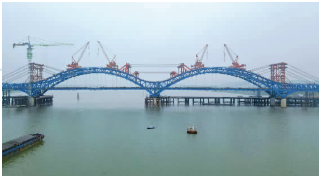
11月26日,全国首座“双飞燕”四跨连续中承式钢桁拱柔性系杆拱桥——暮坪湘江特大桥全桥顺利合龙。 通讯员 供图
