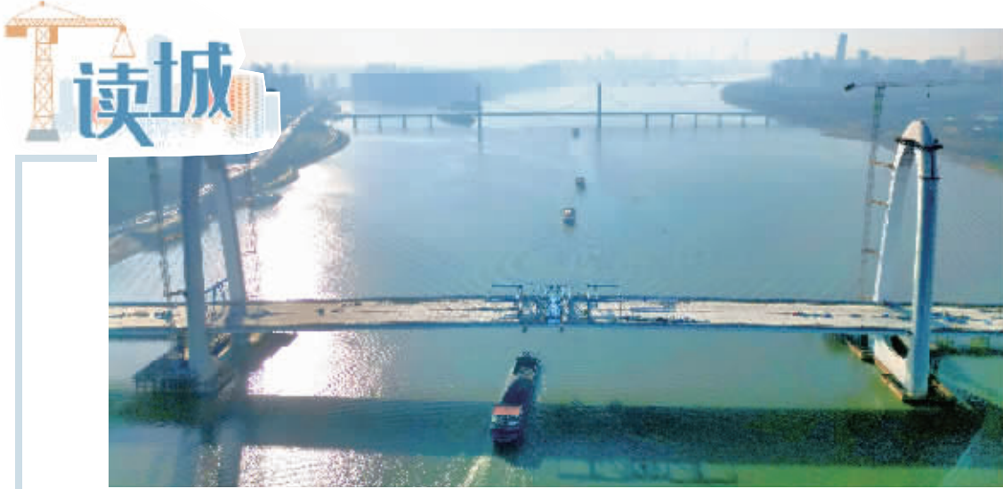
11月8日,长沙兴联路大通道主桥合龙,项目全线贯通。
