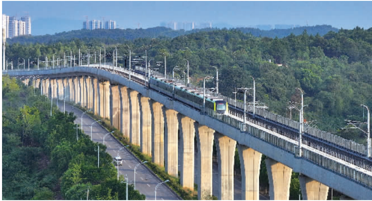
长株潭城际轨道交通西环线开启长沙、湘潭“同城”时代。湖南日报全媒体记者 辜鹏博 摄
