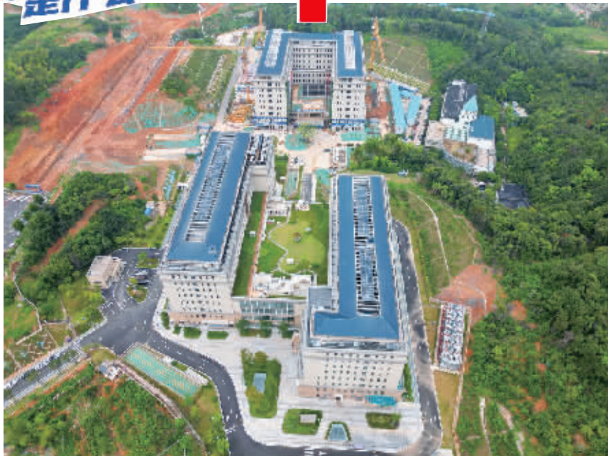
长沙市公共卫生救治中心施工现场图。
