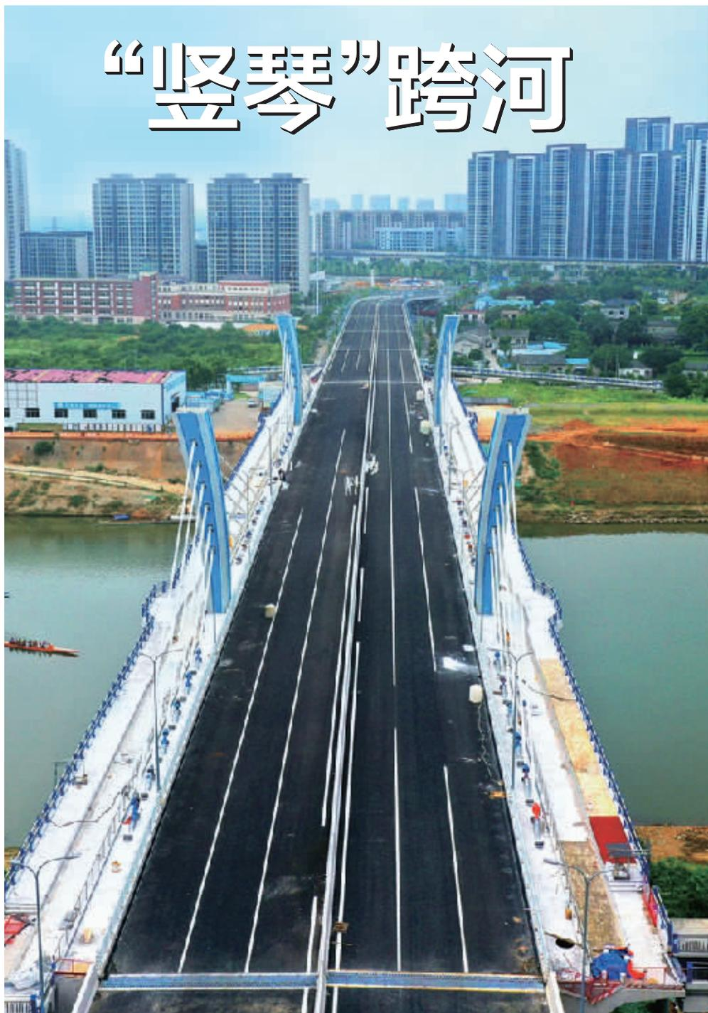
8月13日,由中建五局承建的长沙市金桂路跨浏阳河大桥项目已基本完工。该项目南临长沙国际会展中心,北接高铁片区,含道路工程、桥梁工程等市政配套设施建设内容。金桂路主路建设里程1.4km,主线为城市主干路,双向六车道,设计速度50km/h。主桥采用双索面竖琴式矮塔斜拉桥设计。建成后,将成为长沙市民出行又一重要通勤通道。
