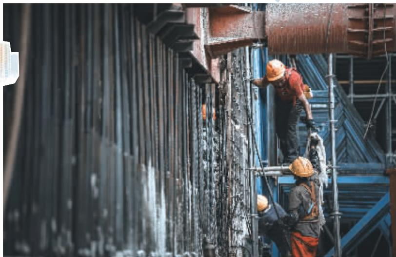
长沙地铁7号线一期工程施工现场,作业人员正在抓紧进行侧墙施工。
