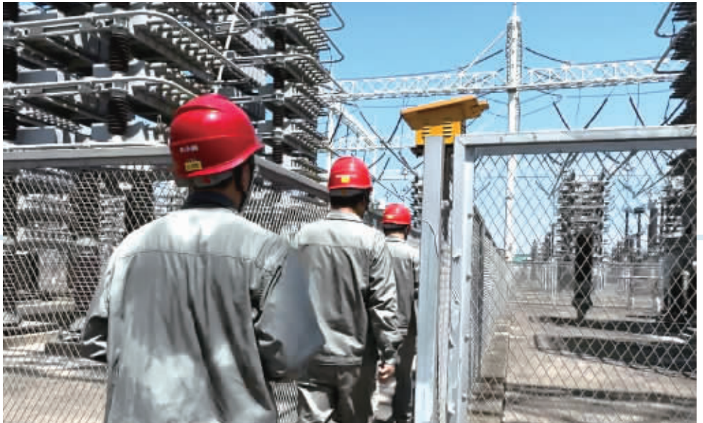
8月6日,闫昊辉对电力设备进行巡检。仅10多分钟的检查,闫昊辉和同事后背就已湿透一大片。
