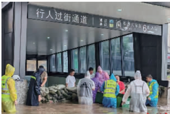
长沙火车站西广场南,北地下通道出入口,志愿服务队员用沙袋筑起防水墙。
