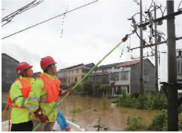
7月28日,衡东县草市镇,电力部门工作人员在进行断电抢险作业。曹正平 贺文奕 摄
